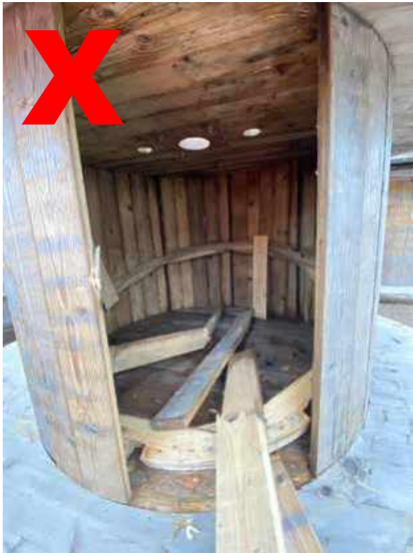
4. RL Rumpulautoja puuttuu
