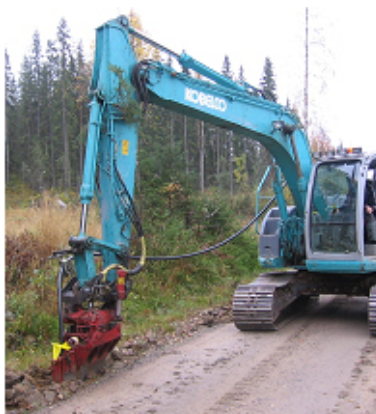
0,6/1 kV kabelplöjning
