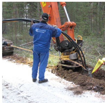
24 kV kabelplöjning DRYREX AHXAMK-W
