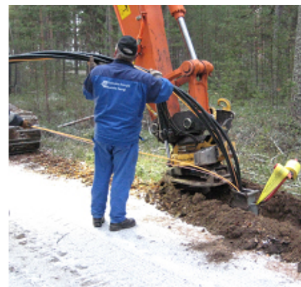
24 kV kabelplöjning DRYREX AHXAMK-W
